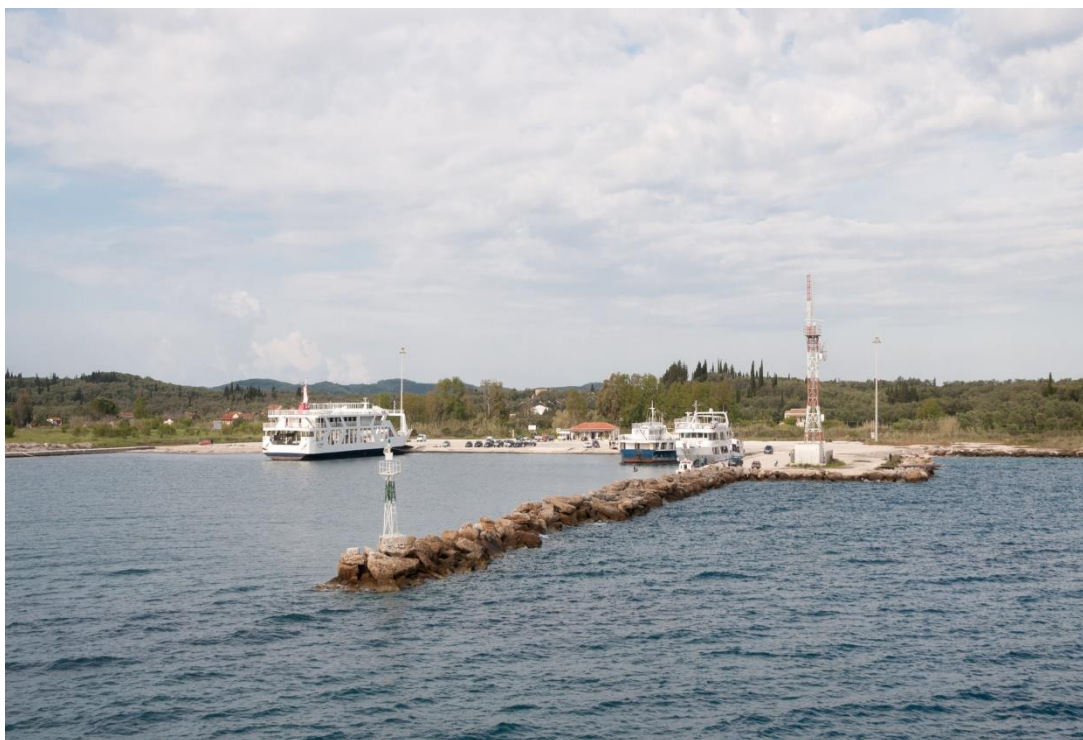
Φωτ. 6: Άποψη υπήνεμου μώλου λιμένα και βόρειας εξωτερικής θωράκισης
